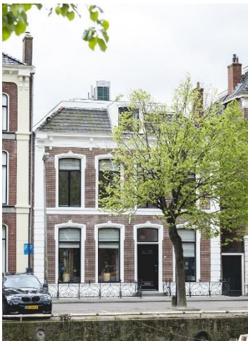
Het monumentale pand in Leeuwarden, met op het dak de buitenunits.
