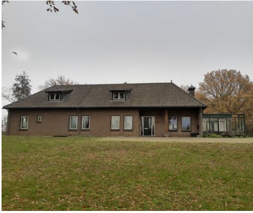
Het huis van Jan de Vaan uit 1974 dat nu met een warmtepomp verwarmd wordt.
