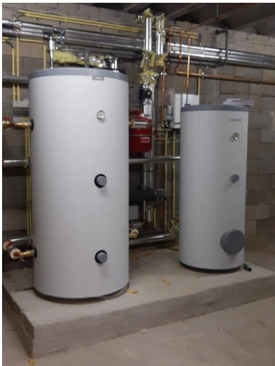
Het grote buffervat is voor de verwarming, het kleinere voor het tapwater.
