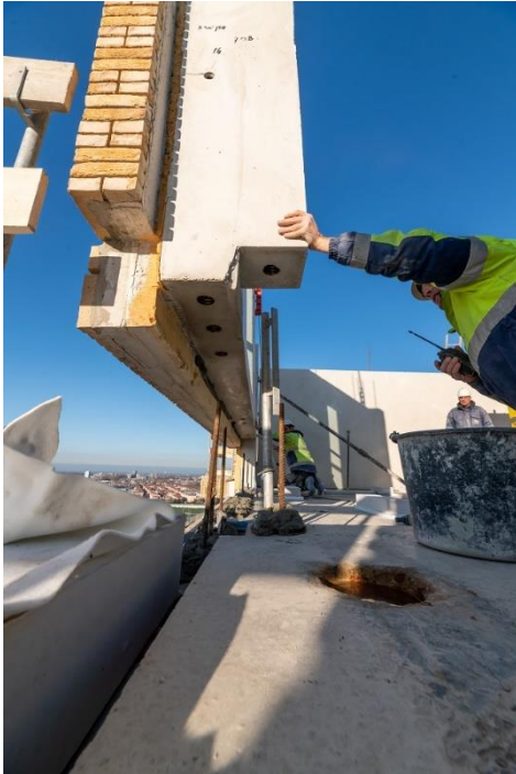
De bouw verliep in een tempo van één verdieping per week.
